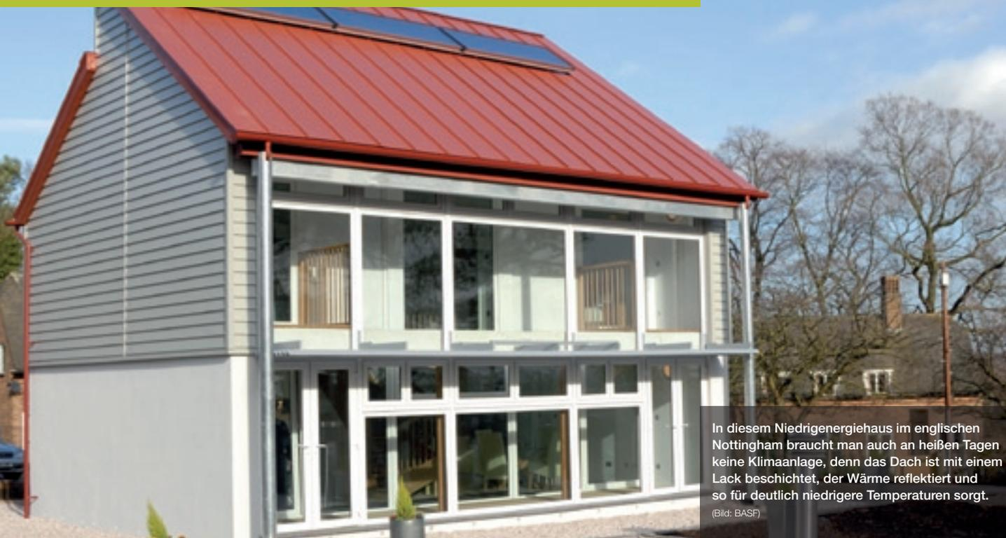
In diesem Niedrigenergiehaus im englischen Nottingham braucht man auch an heißen Tagen keine Klimaanlage, denn das Dach ist mit einem Lack beschichtet, der Wärme reflektiert und so für deutlich niedrigere Temperaturen sorgt.
