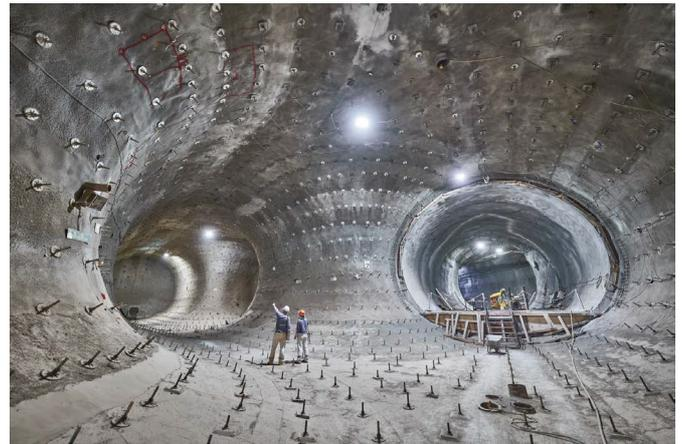
**Abb. 1:** Schachtanlage Konrad; links: Luftbild Schacht Konrad 1; rechts: Ausbau des ehemaligen Eisenerzbergwerks zum Endlager für radioaktive Abfälle mit vernachlässigbarer Wärmeentwicklung. [8]
