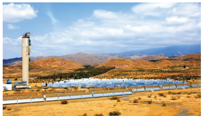
Solarturm auf Plataforma Solar de Almería (Eigentümer: Forschungszentrum CIEMAT/Spainien). Bild: DLR/Markus Steuer.
