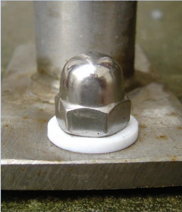
**Abb. B5: Verhinderung von Kontaktkorrosion durch geeignete konstruktive Maßnahme**
