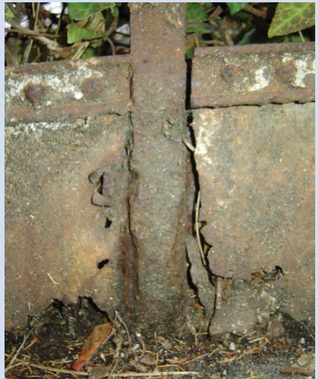
**Abb. B7: Schadbild bei Korrosion durch unterschiedlichen Sauerstoffzutritt.**
