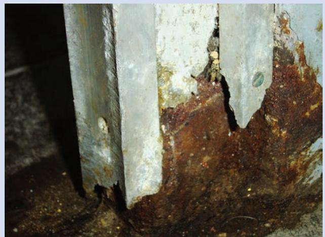
**Abb. B3: Kontaktkorrosion durch konstruktive Mängel befördert**
